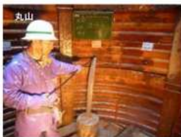
洗浄工の状況（丸山地区）
