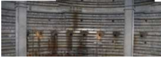
図 2.2.2 (1) 洗浄前の集水ボーリングの目詰り状況
