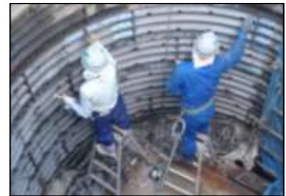
図3 集水井内塗装作業状況
