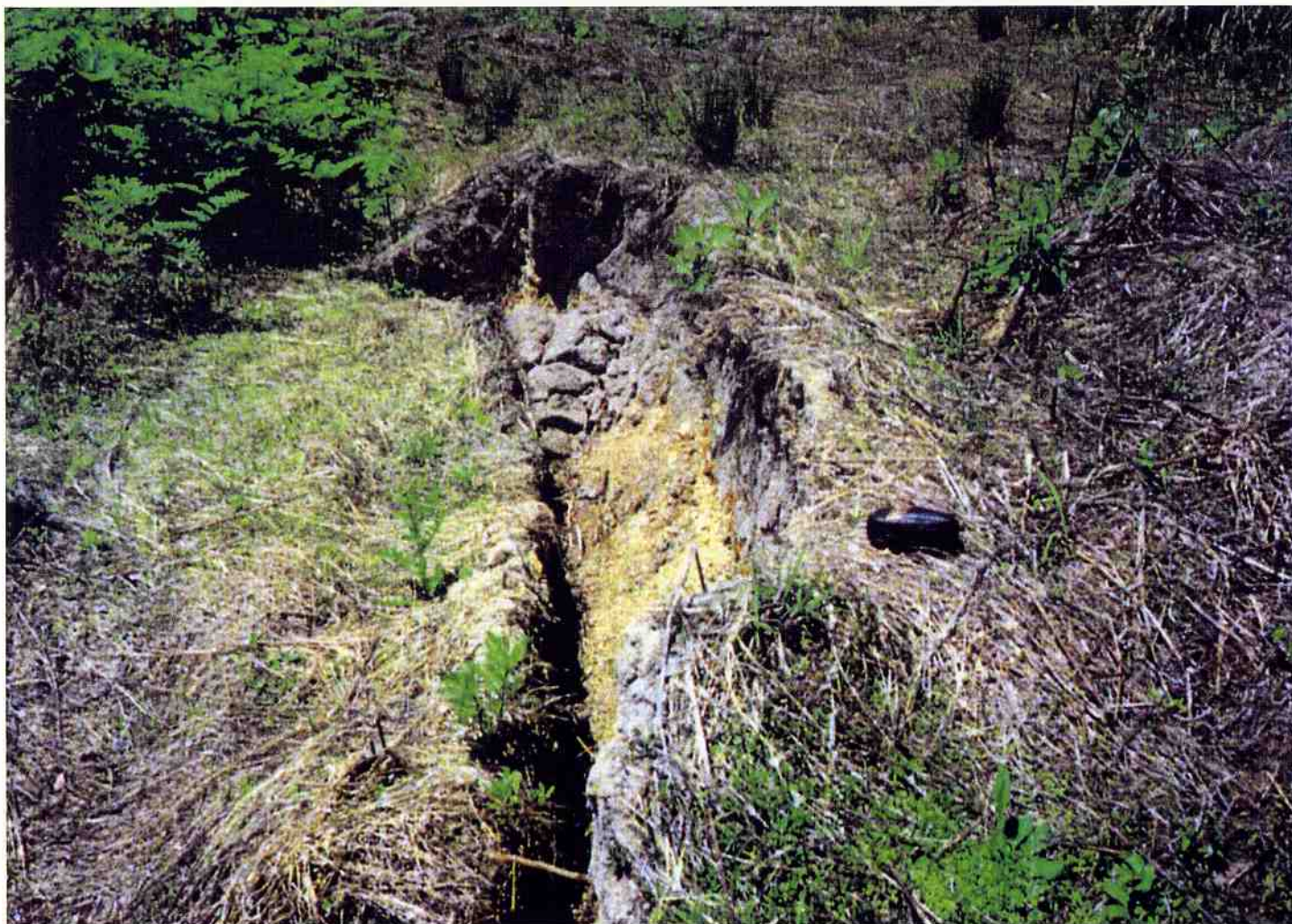
耕作放棄地の上部に発生したクラック
