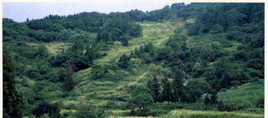
平成6年4月、地すべり防止区域「太田入」地区で起こった地すべり
