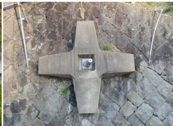
独立受圧板（コンクリート製）
