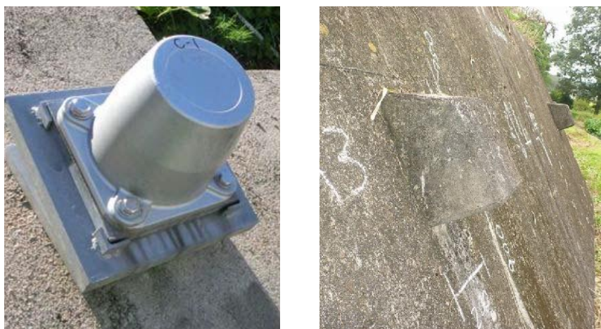
図 3-3 アンカー頭部の外観例 (左：頭部キャップ 右：頭部コンクリート)
