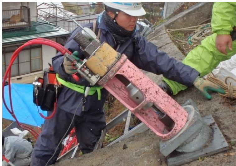
図 3-32 リフトオフ試験状況（小型軽量ジャッキ）
