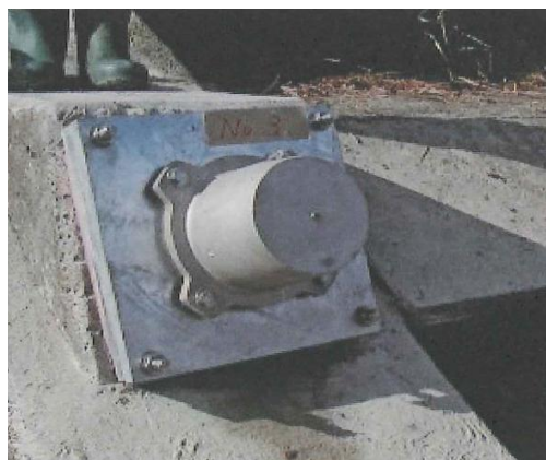
④頭部補修 コンクリートによる保護は、維持管理上適当でないため、調査後は原則として頭部キャップを採用する。頭部キャップの取り付けに対しアンカー頭部周辺の加工が必要。
