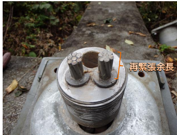
図 3-27 テンドンの再緊張余長部の例
