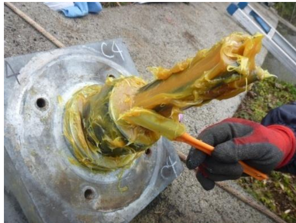
図 3-28 防錆油除去の状況
