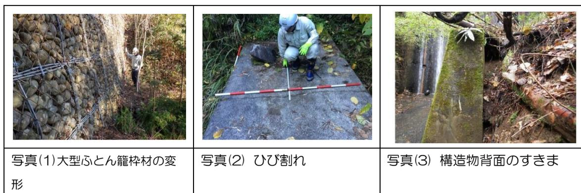
図 4.2.3 異常事例(渓流護岸工)
