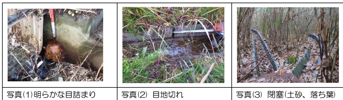
図 4.2.1 異常事例(暗きょ工・明暗きょ工)
