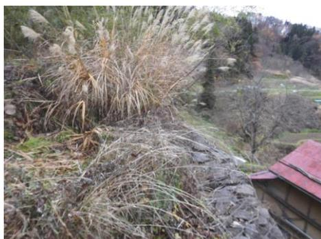
③擁壁の上部の状態(背面に隙間なし)
