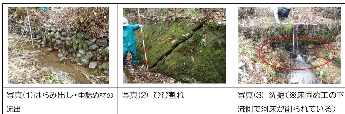
図 4.2.2 異常事例(溪流護岸工)
