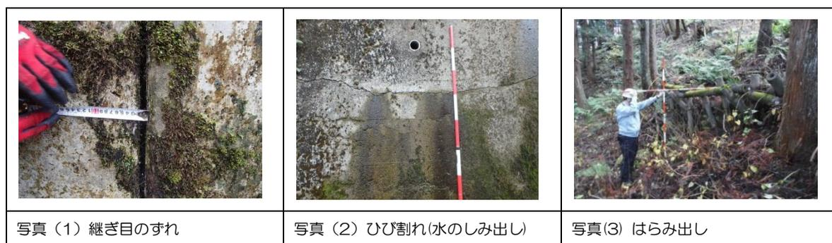
図 4.2.5 異常事例(擁壁(柵)工)
