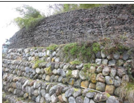
②近景(上5段:黒い石=中詰材は割栗石 下3~4段:白っぽい石=中詰材は栗石)
