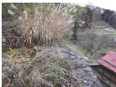
③擁壁の上部の状態(背面に隙間なし) (※植生があり、見通せない部分もあった。)
