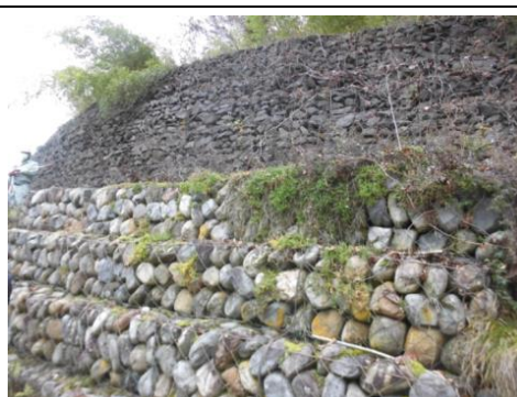
②近景(上5段:黒い石=中詰材は割栗石 下3~4段:白っぽい石=中詰材は栗石)
