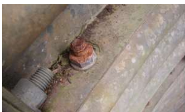
連結金具の腐食 (ライナープレートは錆びずにボルトのみ錆発生)
