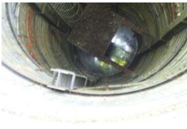
外力による変形 (ライナープレート、パーティカルスティフナーの変形)
