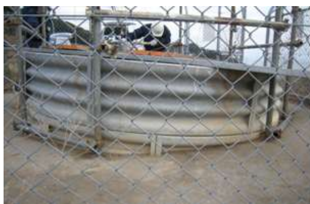
井筒の傾き (根固めコンクリートに変状が無い場合、施工時のものと推定)
