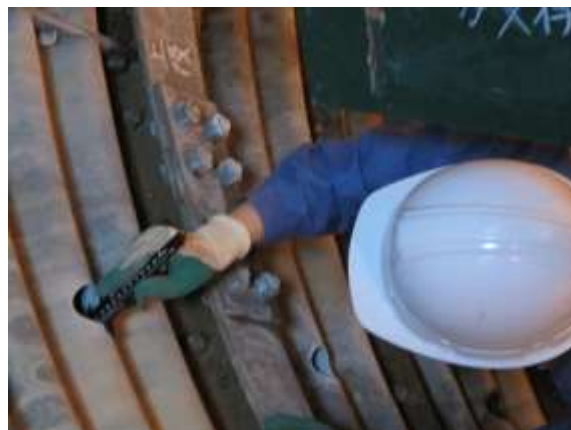
図 3.6.8 ライナー残存厚測定状況
