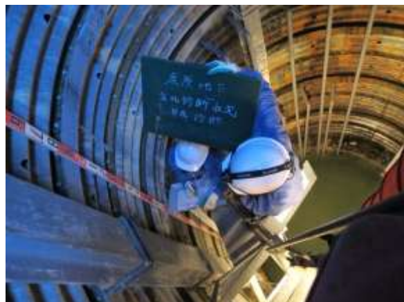
図 3.6.11 劣化診断（目視点検）状況
