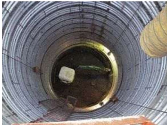
掘削作業状況
