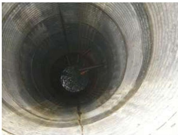
写真 2.2.8 管理人孔（ \phi 1m ライナープレート+砕石詰）施工事例
