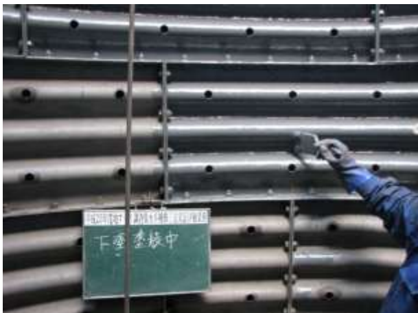
下塗り塗装作業
