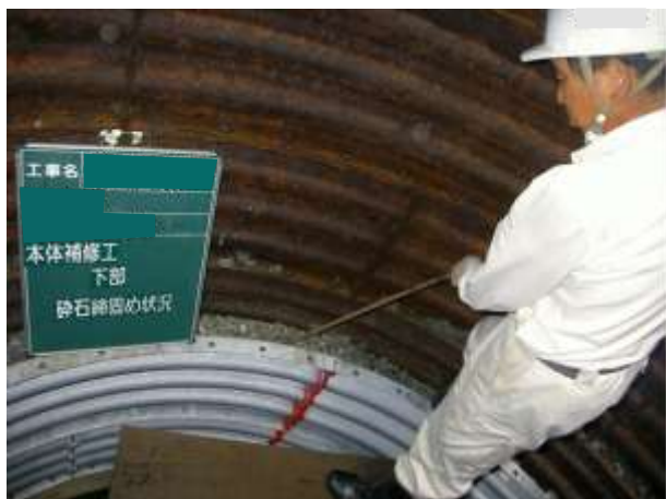
裏込め砕石締固め
