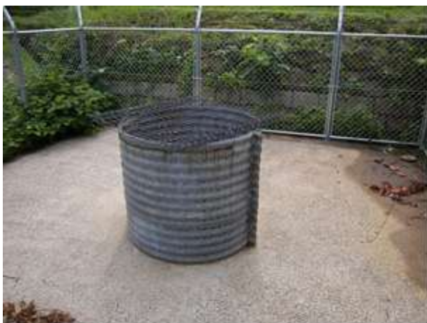
写真 2.2.8 管理人孔（ \phi 1m ライナープレート+砕石詰）施工事例
