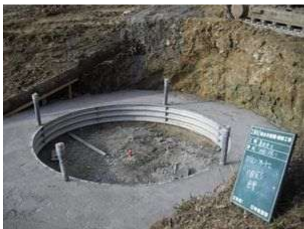
埋戻し・坑口付完了
