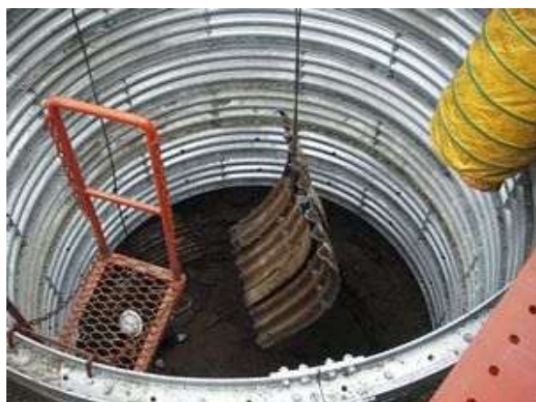
旧ライナープレート吊り出し状況
