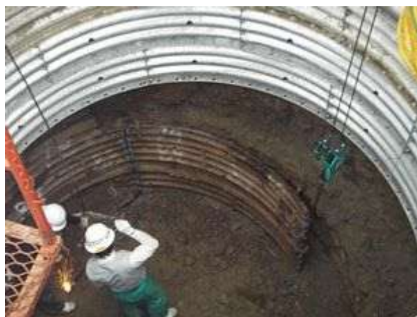
旧ライナープレート取り外し状況
