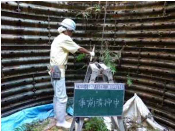
事前清掃（植生除去）作業
