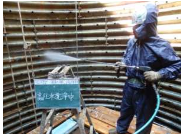
高圧水による壁面洗浄
