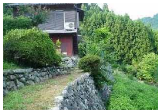
石積みで法面の崩壊を防ぐ （法面の安定対策）
