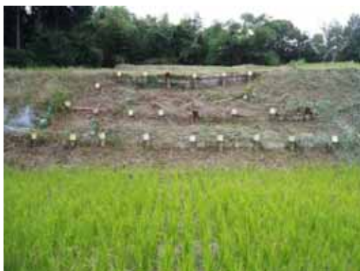
畦に木柵を設置し、畦の崩壊を防ぐ （法面の安定対策）
