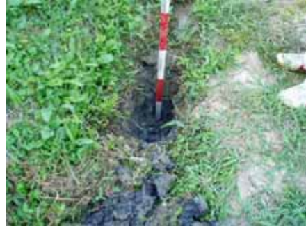
籾殻を敷いて暗渠とする
