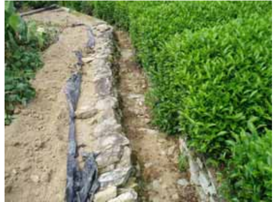
石積で水路を作る（流入防止）
