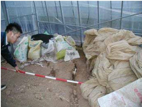
図 3-7 農地に発生した亀裂
