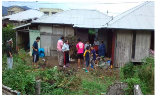
写真2 地域ぐるみで空き家を改修
