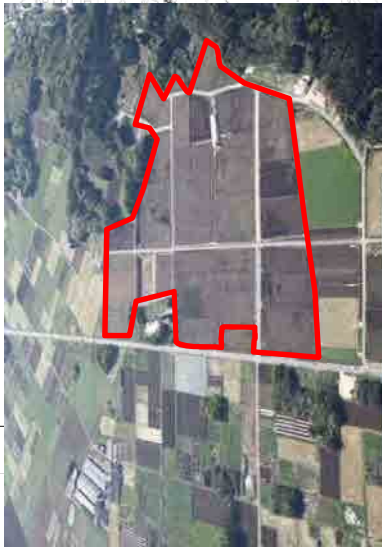
区画整理(本地区の北東部)
