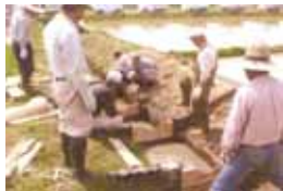
排水路堰上げ式魚道の設置設置
