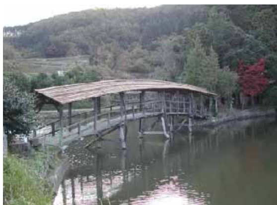
（屋根つき木橋（田丸橋））
