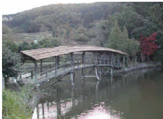
（屋根つき木橋（田丸橋））
