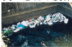
整備前の状況 (羽島水路)
