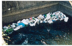
整備前の状況 (羽島水路)
