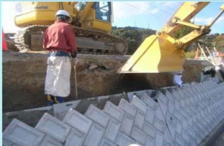
バックホウによる投入状況
