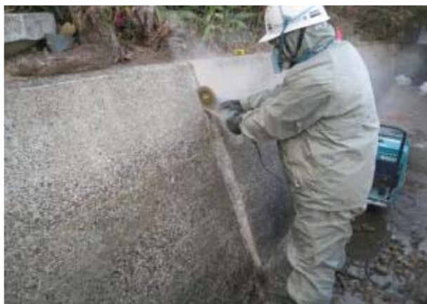
既設目地撤去状況
