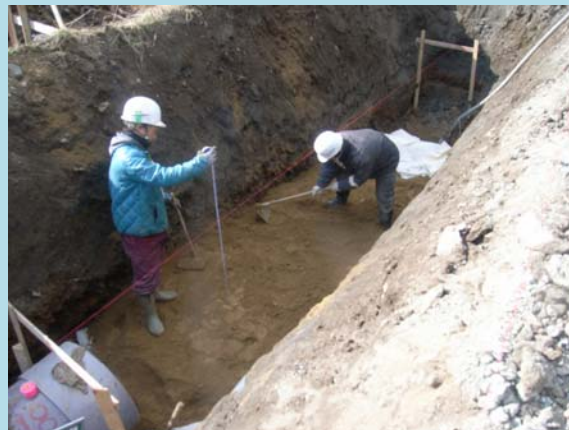
基礎材のまき出し状況
