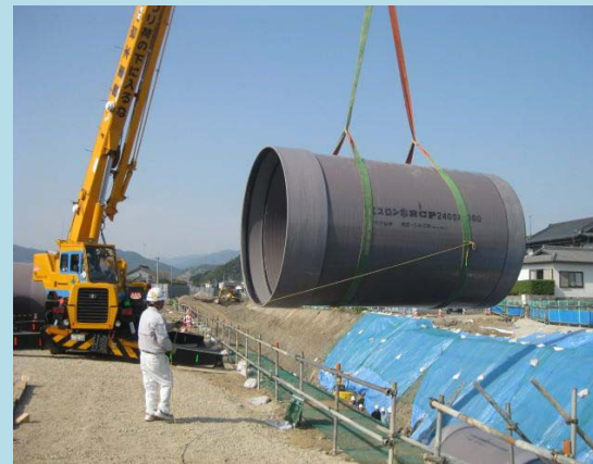
ラフテレーンクレーンによる施工状況
