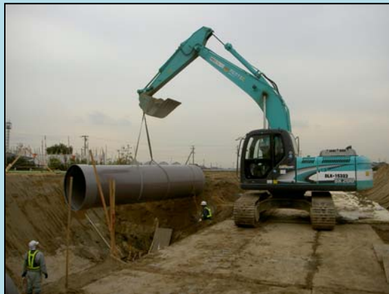
バックホウ(クレーン機能付)による施工状況
