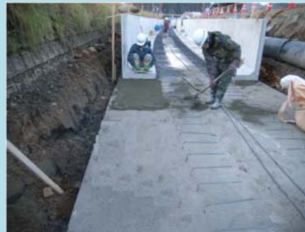
敷モルタルの施工状況
