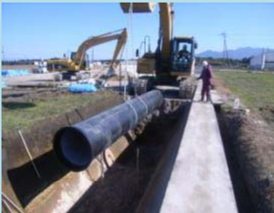
バックホウ(クレーン機能付)による施工状況
