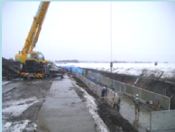
ラフテレーンクレーン25t吊による施工状況
