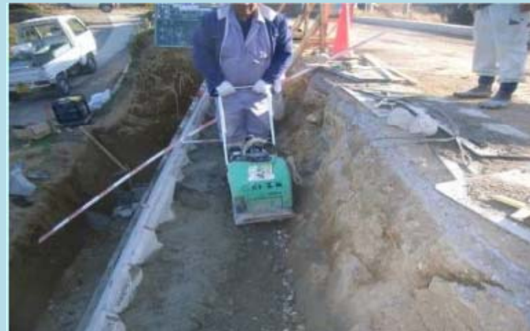
振動コンパクタによる締固状況
