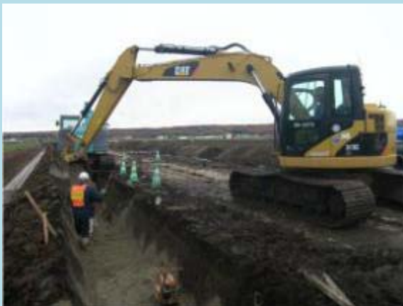
基礎材投入状況
