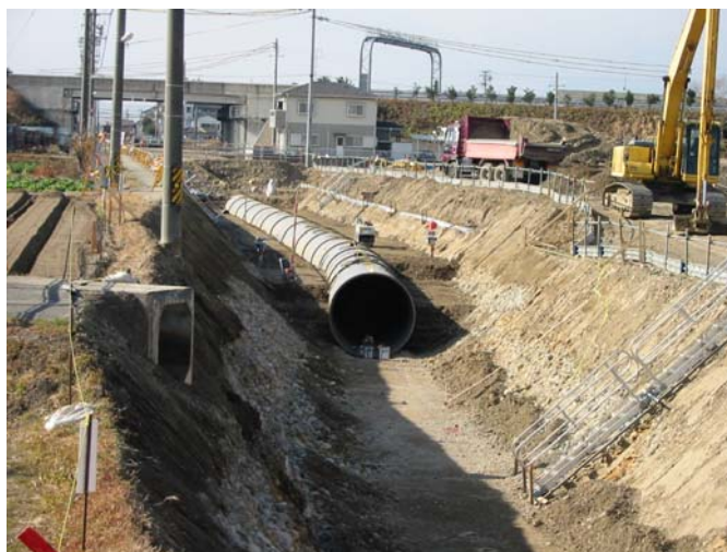
図 11 曲げ配管状況
