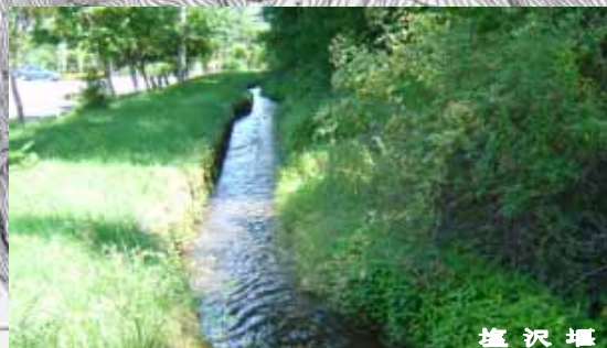
1646年に初代六川長三郎勝家によって疎水に成功した塩沢堰は、立科町とその周辺地域（570ha）を潤す農業用水路であり、女神湖へのどう水路としても重要な役割を果たしている。
