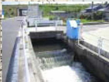
右岸幹線用水路 分水工
