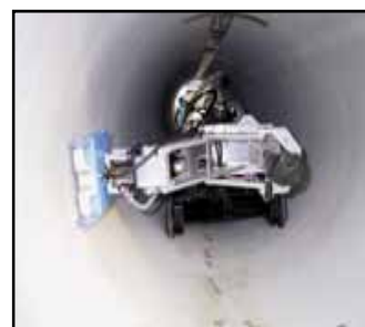
無人調査機により、パイプライン周辺の空洞化等危険箇所を調査
