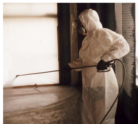
(薬液散布による石綿の湿潤化)
