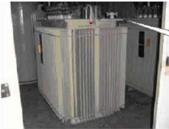
変圧器 配管フランジ部のパッキン及びバルブ軸部のシールガスケット
