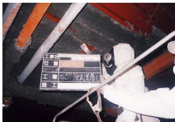
(石綿除去作業(手作業によるかき落とし))
