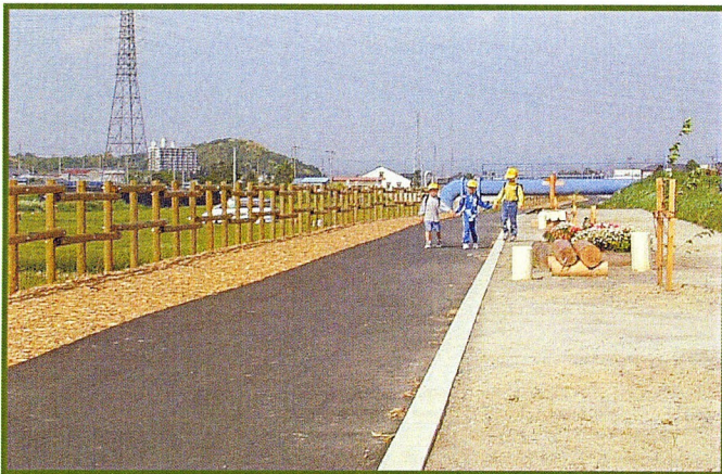
《整備後の状況》
