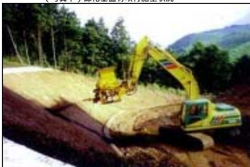
(写真上) チップ処理の施工状況 (写真下) 緑化基盤材吹付施工状況
