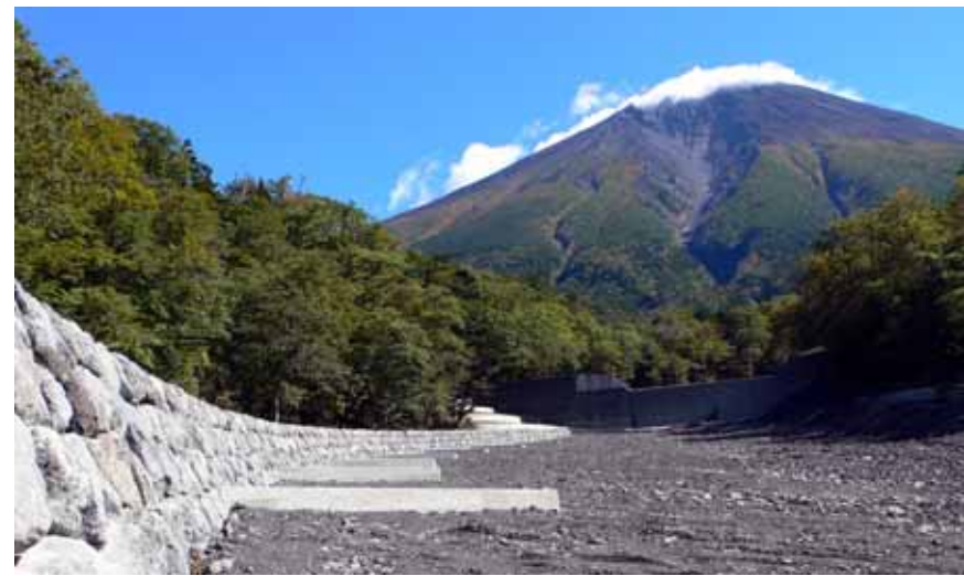
石積護岸工の完成状況
