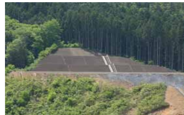
原石山斜面部へのチップ材吹付
