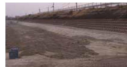
押え盛土の完成
