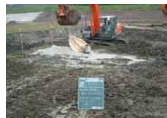
セメント改良固化の施工状況
