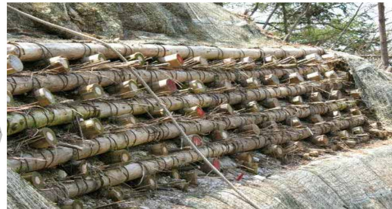
伐倒木を利用した 丸太積土留工
