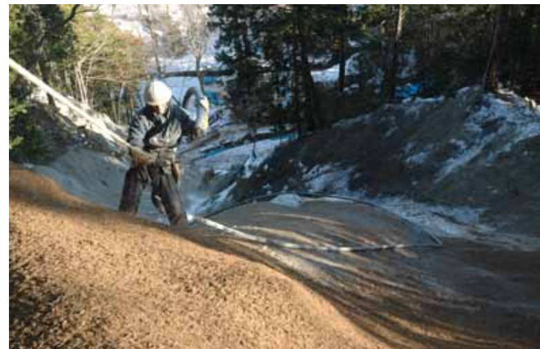
木材チップと緑化基盤材を混合し吹付けている状況
