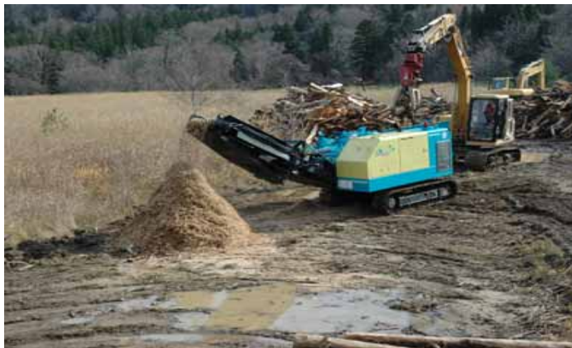
集積した流木の破砕(チップ化)処理の状況
