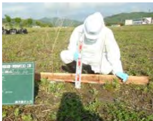
写真 8 不陸整正前の段差確認 (草野向押③—1 90mm)
