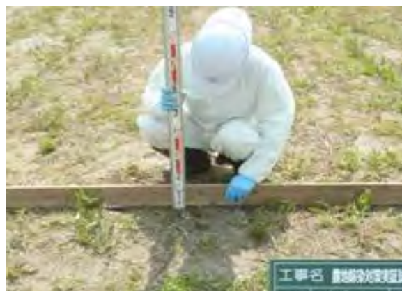
写真 9 不陸整正後の段差確認 (草野向押③—1 15mm)
