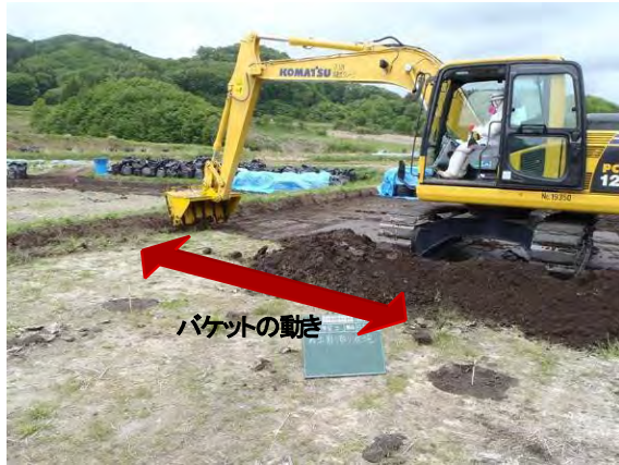
写真 5 バックホウで表土を削り取り （バケットを前後に動かす）
