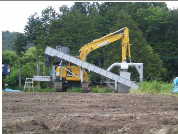
写真 10 直結したコンベアで大型土のうに詰め込み
