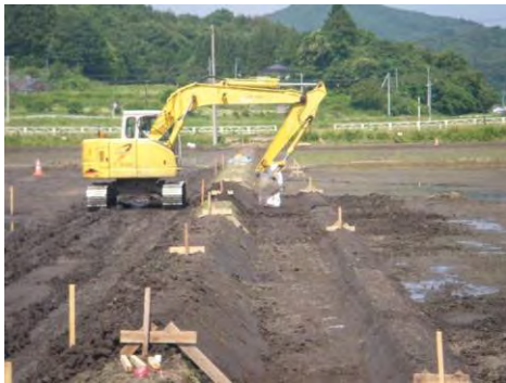
写真 19 準備作業（導水路掘削・越流堤設置）
