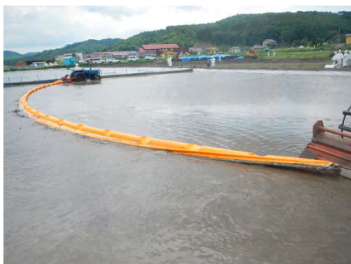
写真 23 オイルフェンスによる濁水排水
