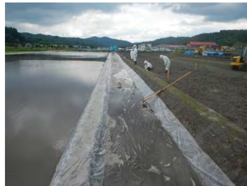
写真 20 導水路へのシート敷設
