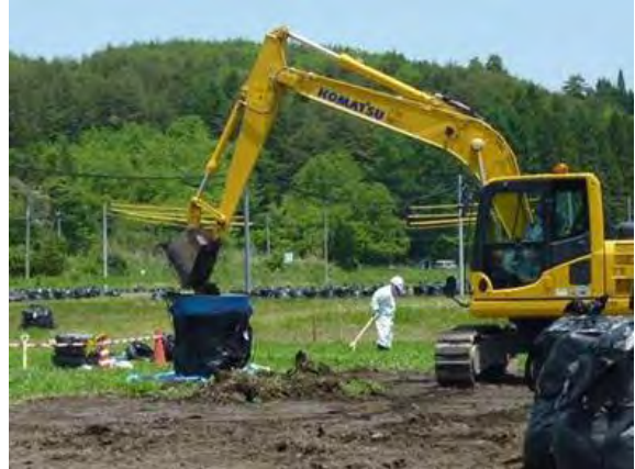
写真 6 大型土のうに バックホウで詰め込み搬出
