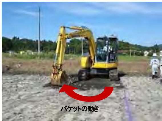
写真 7 バケットのエッジで削り取り （バケットを一方向にスウィングさせる）
