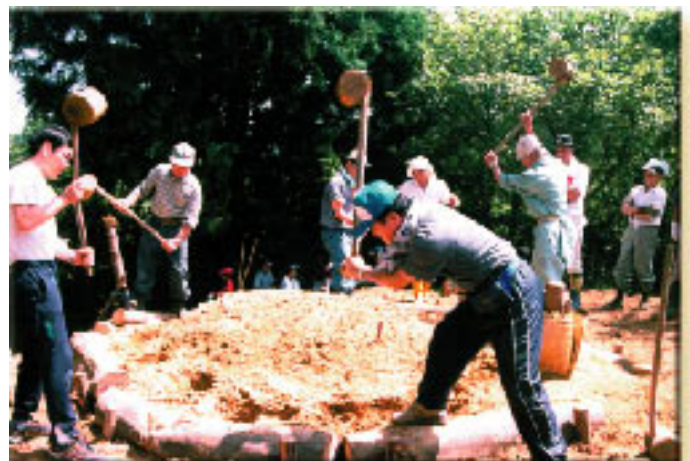
除間伐材を活用するために、昔ながらの方法で黒炭窯を復活させた
