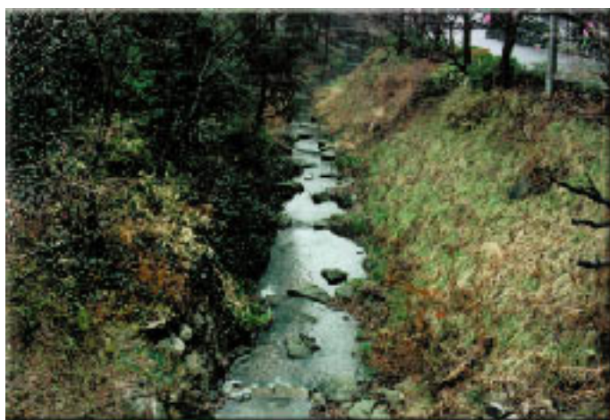
農業用水路に水制工を施し、生物が生息する環境を整える
