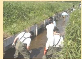
多種の魚類が生息できるように魚巣ブロック内の詰石を改良
