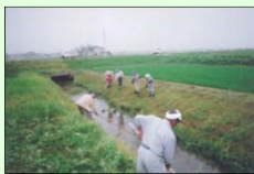
水路の泥上げ (日常の管理)
