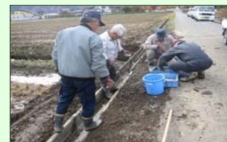
水路の補修 (施設の長寿命化)
