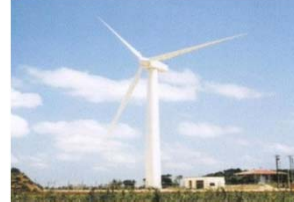
農業水利施設に供給する風力発電
