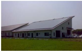
農業水利施設に設置した太陽光発電
