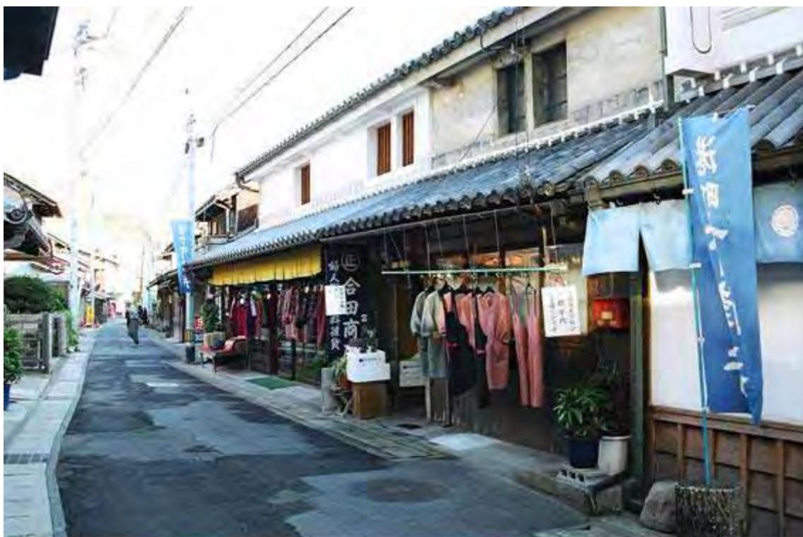
写真 2-6 下津井町並み保存地区
