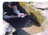
水路のひび割れ補修
