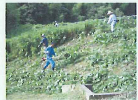
法面等の管理
