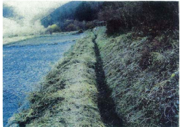
水路清掃作業
