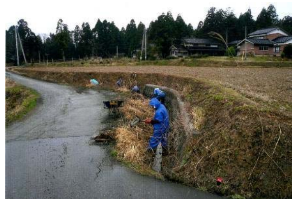
水路清掃作業
