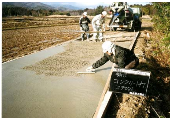
コンクリート舗装作業
