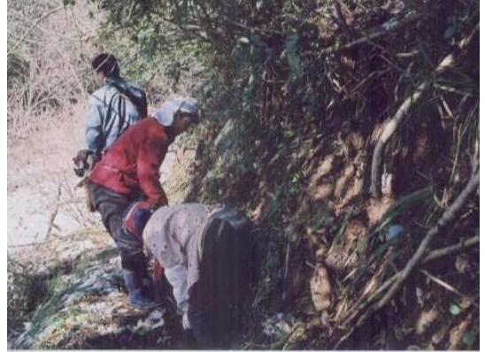
水路の補修・管理(砂子坂集落)
