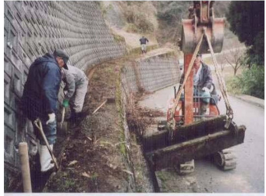
水路の目地補修(土子原集落)
