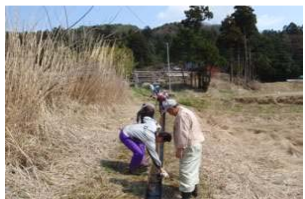
水路の江堀り作業 （荒屋集落）
