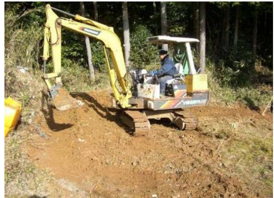
農道の簡易補修作業機械
