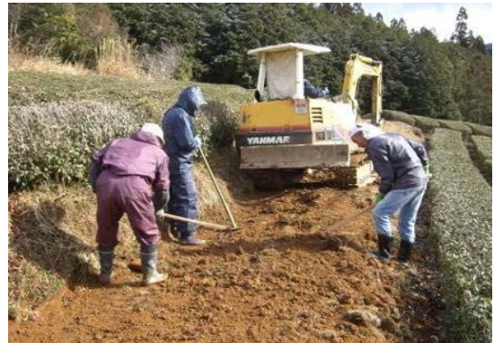
農道の簡易補修作業風景(2)
