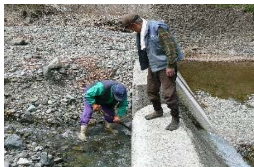
頭首工管理作業
