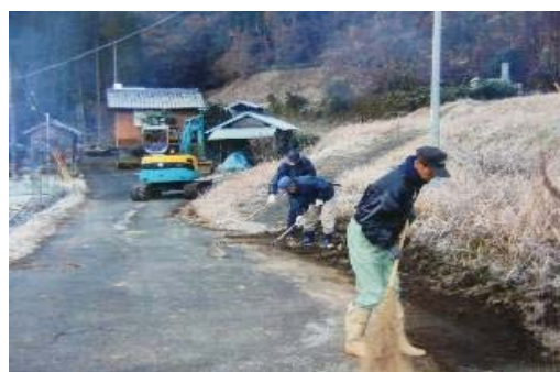
農道土砂除去作業
