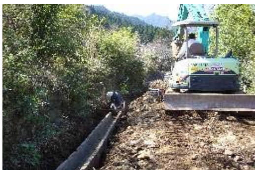
水路布施替え作業
