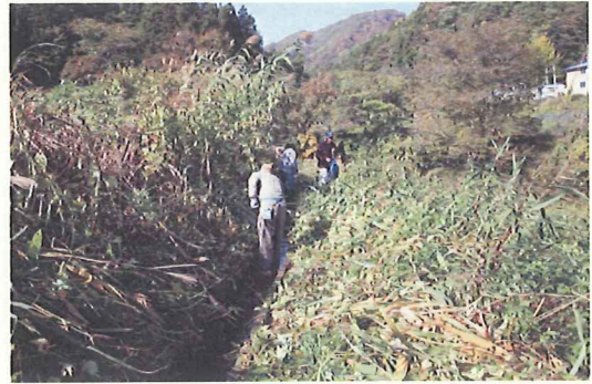
水路保全作業
