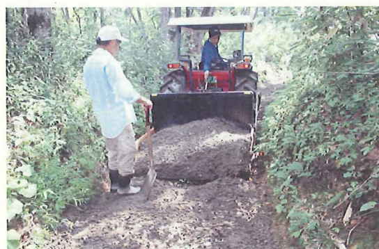
農道整備作業
