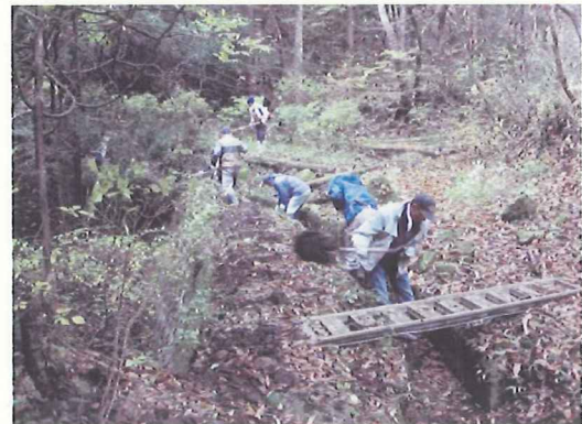
水路泥上げ清掃作業
