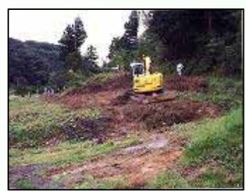
再生作業実施中
