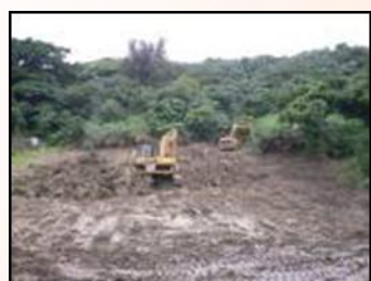
再生作業実施中
