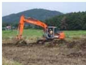
再生作業実施中
