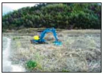
再生作業実施中
