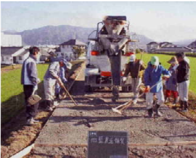
〈非農家も参加し農道を改修〉
