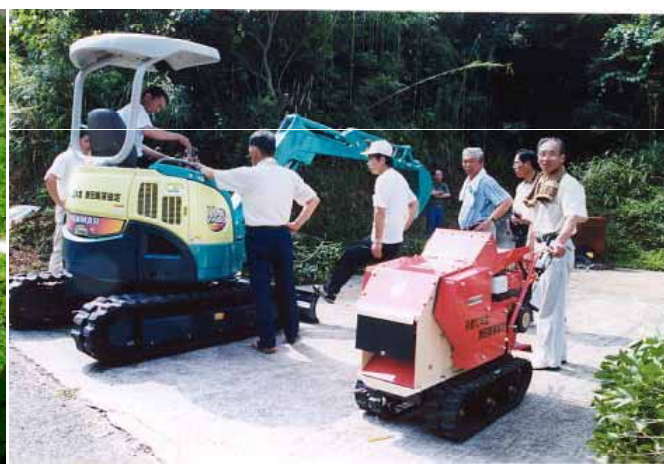
<共同利用機械（バックホー、樹木粉碎機）>
