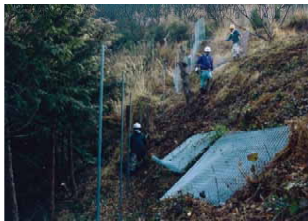
＜鳥獣害防止柵の取り付け作業（傾斜地）＞
