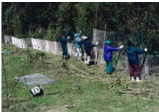
＜鳥獣害防止柵の取り付け作業（平坦地）＞
