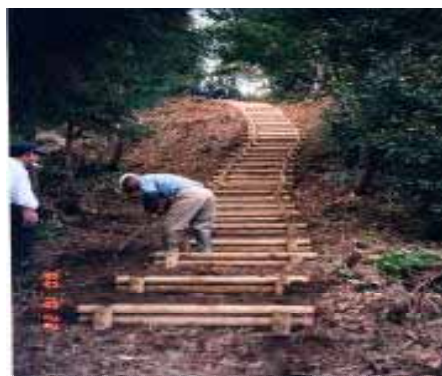
〈遊歩道整備の状況〉
