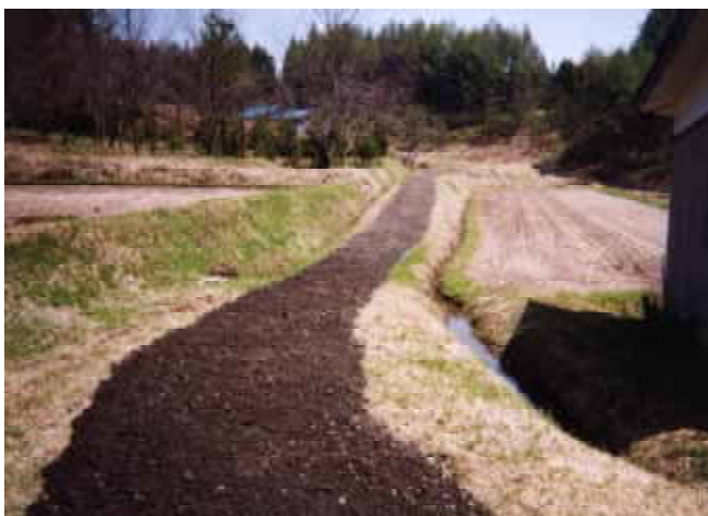
<雨水により洗掘された農道の補修>
