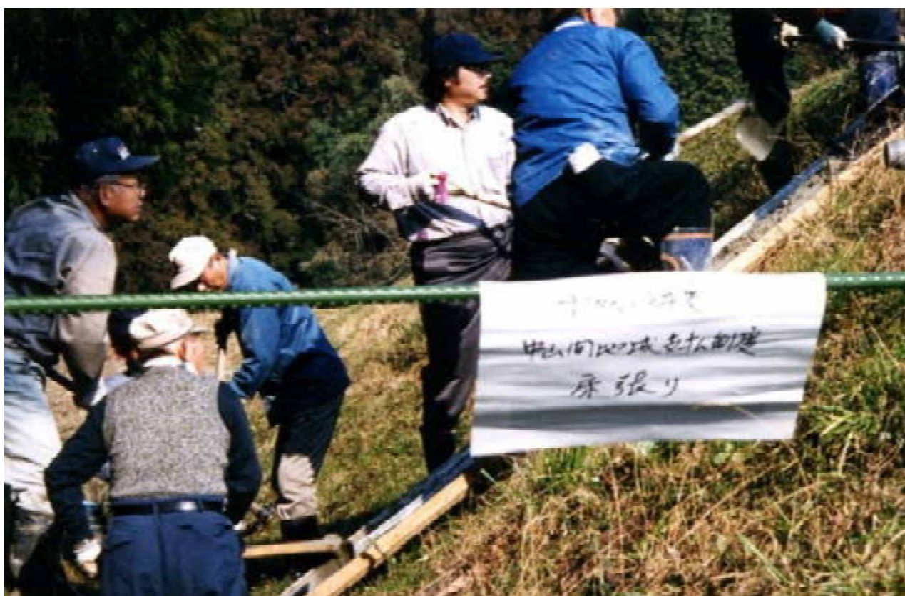
〈排水路の悪臭を防止するための「床張り（生コン打ち）」〉
